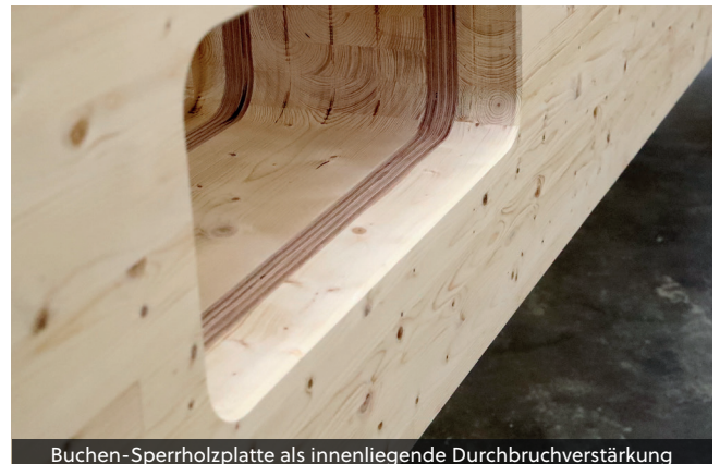
Buchen-Sperrholzplatte als innenliegende Durchbruchverstärkung
